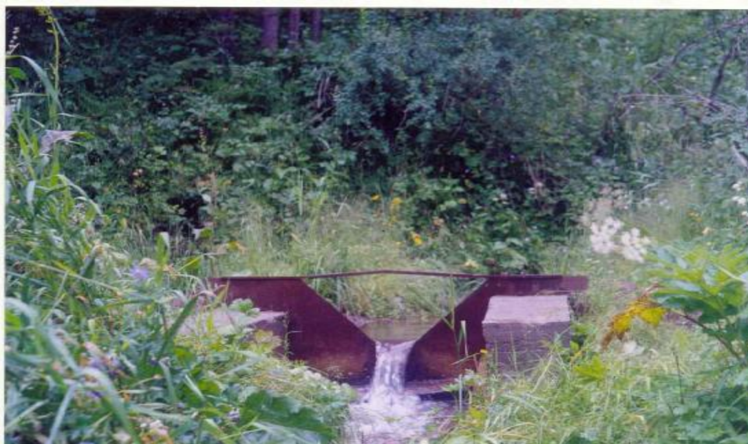
Рис. 13. Водослив в русле водосбора «Адыбаево»
