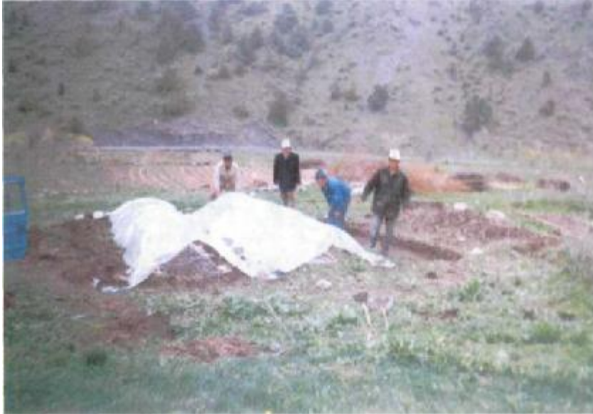
Рис. 8. Укрытие траншеи с контейнерами полиэтиленовой пленкой.
